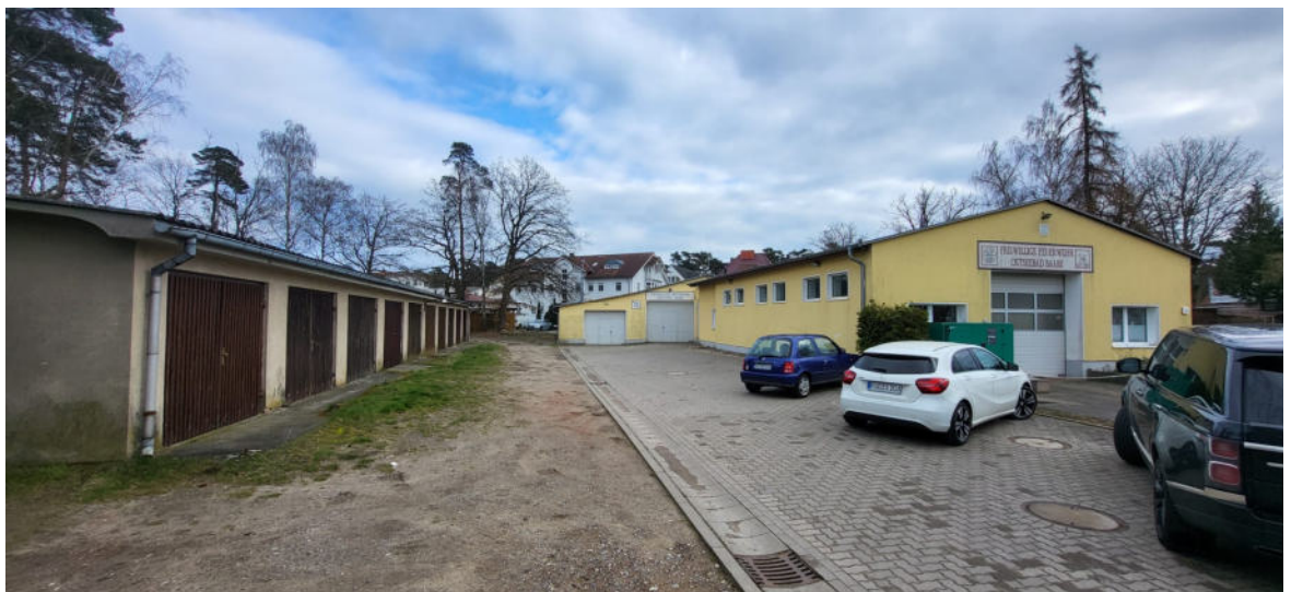
Abb. 4: Bestandsgebäude (eigene Aufnahme)
