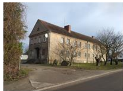
Gebäude Darzer Weg 70
