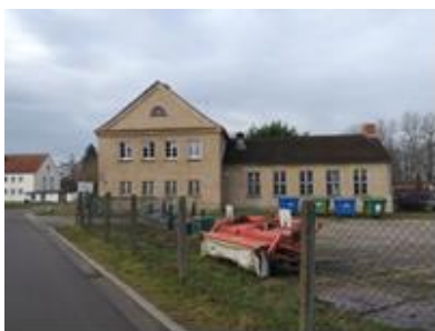
Gebäude Darzer Weg 70
