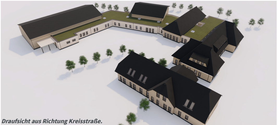
Draufsicht aus Richtung Kreisstraße.
